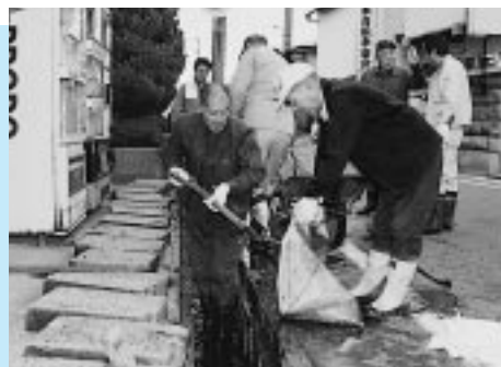
一生懸命側溝のどろあげをする仁井田堅町町内会のかたがた
