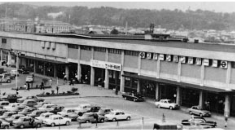
昭和36年9月、秋季国体を前に秋田民衆駅が完成しました。鉄筋コンクリート2階建て、約6,300平方メートルで、それまでの秋田駅の8倍に。平成9年まで多くの市民・県民に利用されました
