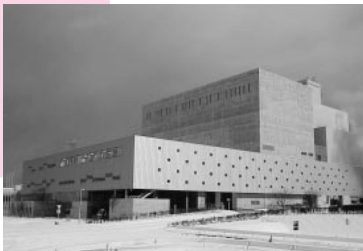
来年4月から本格稼働する御所野の新焼却炉
