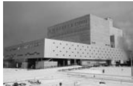
4月から本格稼働する新焼却炉
