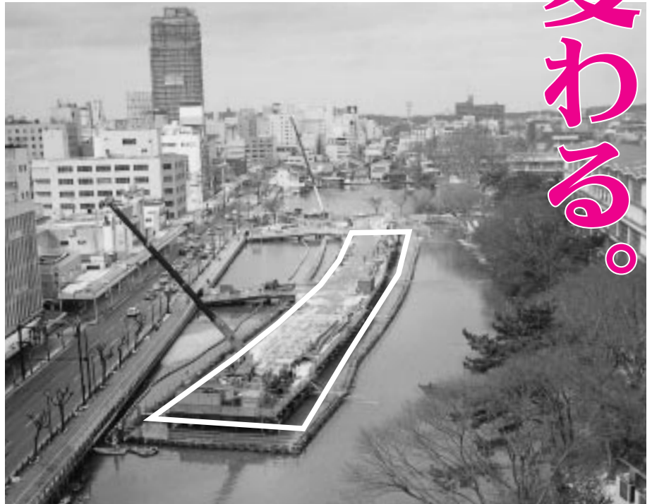
仮設工事が終了した千秋公園のお堀。平成15年度は、地上から掘り下げる開削工事（白い枠の部分）が始まります。工事後は、お堀は元の姿に戻ります。
