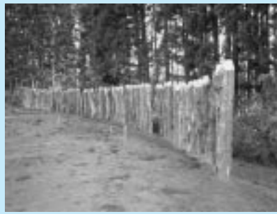
整備された木柵跡。集落を防御する意味合いの強い柵と考えられます
