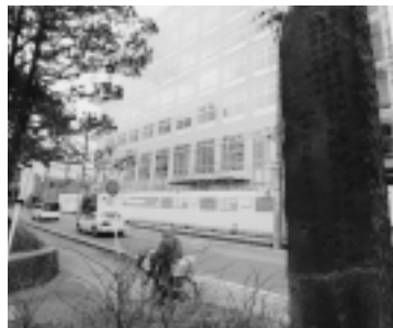
明德館跡を示す碑の向かいでは 来春開校する「秋田明德館高校」 を建設中です
