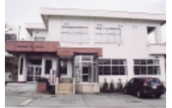
大正寺支所 大正寺連絡所
