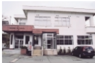
大正寺支所 大正寺連絡所
