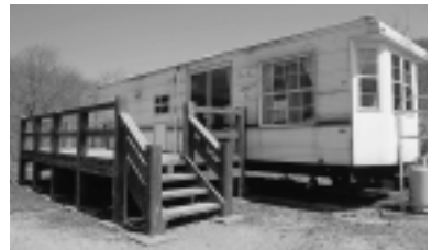
トレーラーハウス
