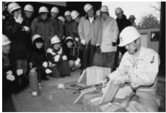
旧黒澤家住宅の保存修理現地見学会で。屋根の材料となる秋田杉を、ナタ1本で薄さ数ミリまでに割る職人の技に...「すご~い!」
