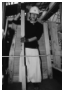
古代と同じ方法で塀の土を固めていきます
