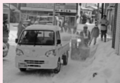
小型除雪機で除排雪(旭南)
