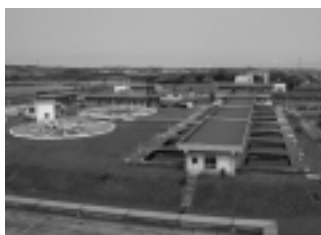
仁井田浄水場
