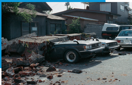
倒壊した塀で押しつぶされた自動車
