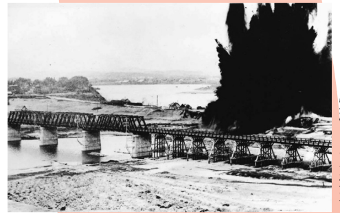
爆破による通水
