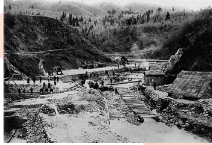
藤倉水源地の工事風景
