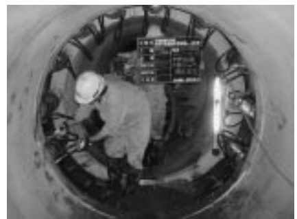
浸水を防ぐ雨水管の工事(保戸野)
