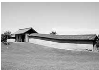
平成10年に復元された外郭東門と築地堀(土を突き固めて造つた堀)。
