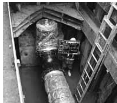
手形山浜田連絡管を敷設
