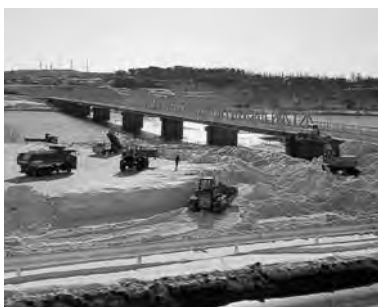
雄物川右岸の堆雪場は、1月中旬に下流側がいっぱいになり上流側にも設置しました
