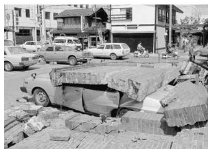
日本海中部地震での被害
