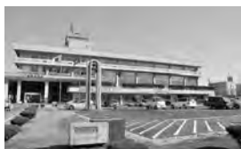
新庁舎建設工事に伴い、庁舎前庭を駐車場に整備しました
