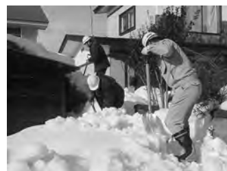
昨シーズンの除雪作業の様子
