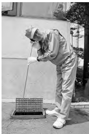
*音聴棒という機器で、振動音を聴きながら漏水の有無を確認します。
