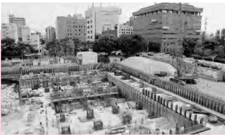
建物の基礎部分を工事中です
