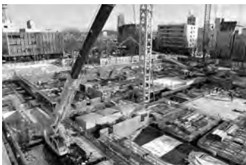
順調に進む新庁舎建設
