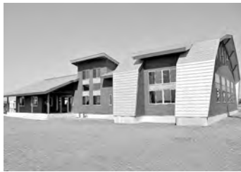
園芸振興センター管理棟
