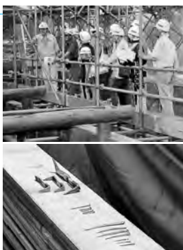
使われている木材や釘 などの年代を確認しな がら修復しています
