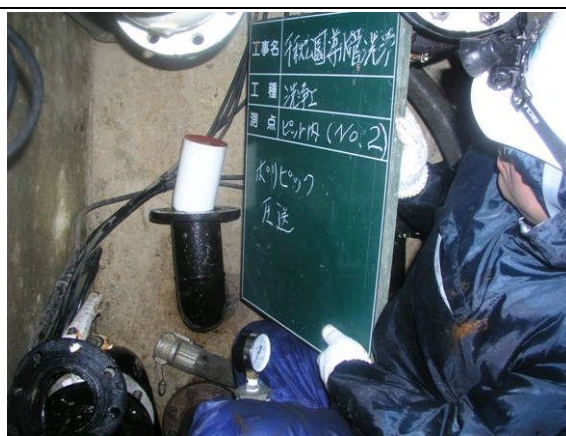
取水ピット ポリピック挿入
