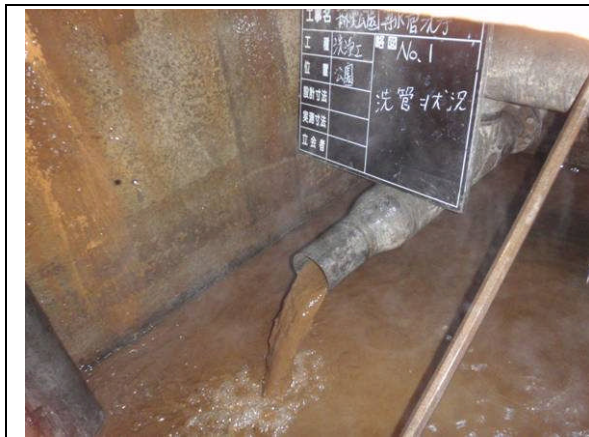
放流ピット No.1 洗管状況
