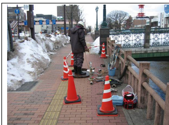
取水ピット作業状況
