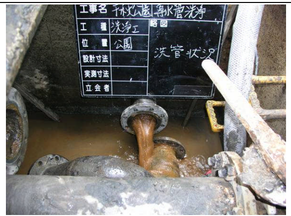
放流ピット No.2 洗管状況
