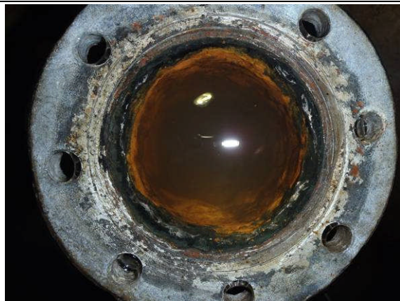
取水ピット 管内清掃後状況
