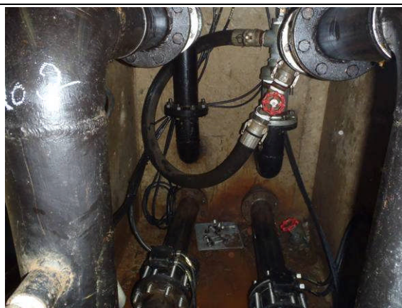
取水ピット ランチャー設置状況
