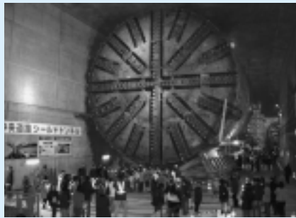
トンネルを掘り進むシールドマシン
