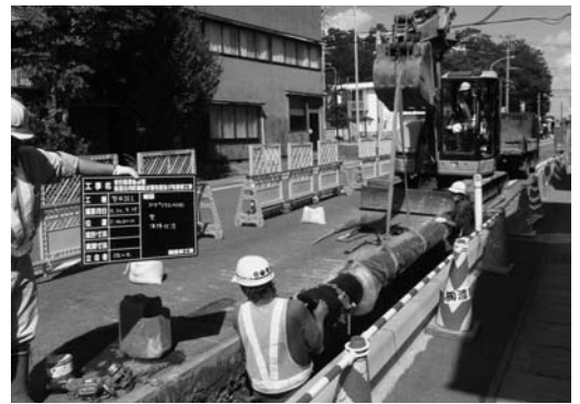
老朽化した水道管の交換作業。漏水や断水を防ぎます(新屋比内町)
