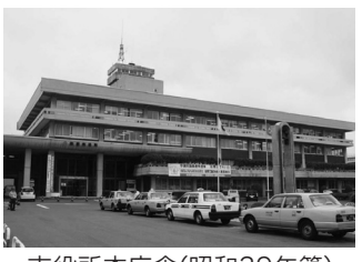
市役所本庁舎(昭和39年築)
