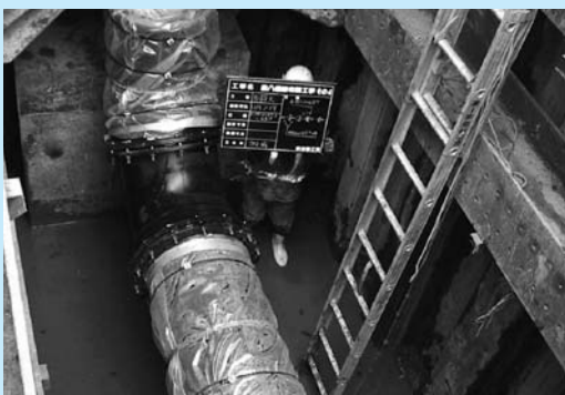
地震に強い水道管を布設しています
