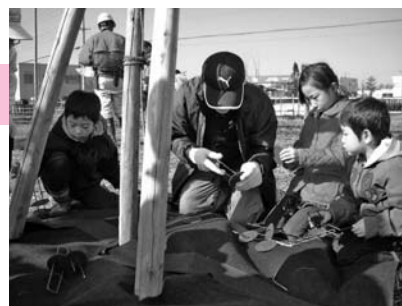
防草シートも設置しました
