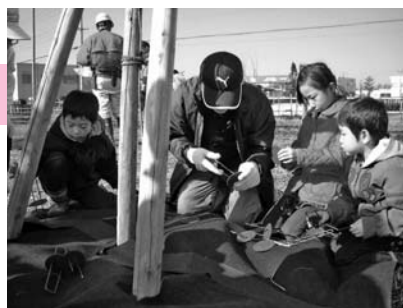
防草シートも設置しました
