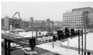
平成24年春の完成をめざしています
