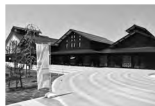
切妻屋根が特徴の建物外観
