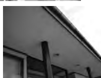
修繕後の軒天井
