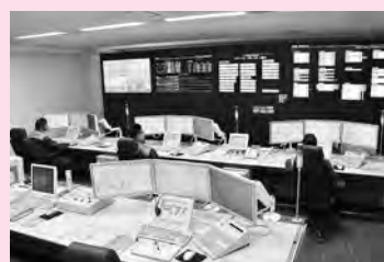
消防総合通信指令システムの更新
