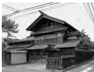
藩政期の町屋形式を今に伝える住宅。明治39年建築。建物内には内蔵も
