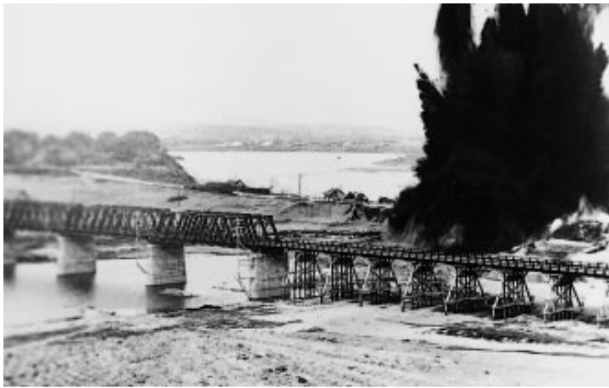
雄物川放水路は、大正6年に着工し、22年の工事を経て昭和13年に通水しました。雄物川をまっすぐ海へ通す2キロあまりの放水路工事は、たび重なる水害の解消や秋田港の港湾整備の基盤を造るのが大きな目的でした。写真は昭和13年4月27日の通水爆破の瞬間
