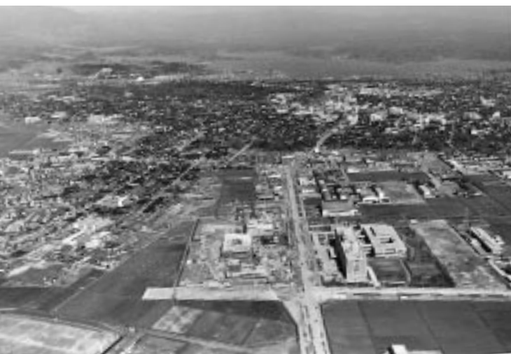
官公庁団地として整備が進む山王地区。県庁は完成し、市役所は建設中(昭和38年ごろ)
