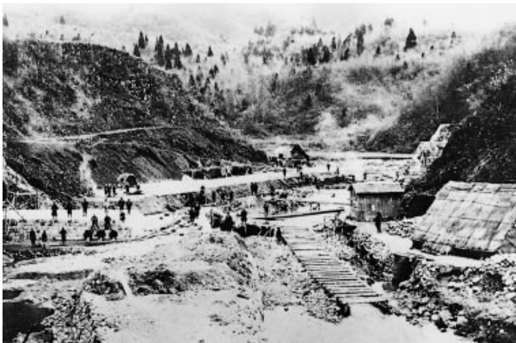
藤倉水源地の工事風景。秋田市が水道工事に着手したのは明治36年。旭川上流の藤倉を水源として、千秋公園まで送水管を通す一大事業でした。総工費は約76万円。当時の市の予算は年3万円ですから、力の入れようが分かります。一般家庭への給水開始は明治40年10月
