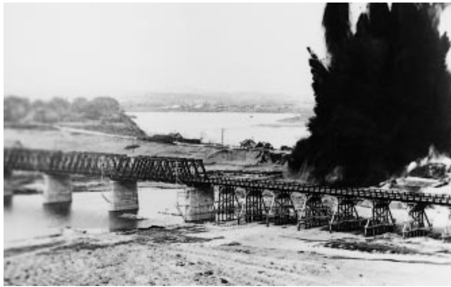
雄物川放水路は、大正6年に着工し、22年の工事を経て昭和13年に通水しました。雄物川をまっすぐ海へ通す2キロあまりの放水路工事は、たび重なる水害の解消や秋田港の港湾整備の基盤を造るのが大きな目的でした。写真は昭和13年4月27日の通水爆破の瞬間
