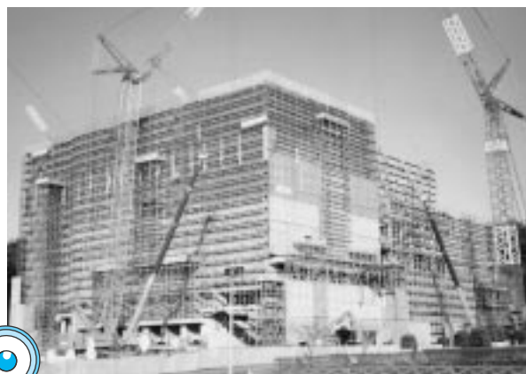
建設中の新しいごみ焼却炉
