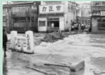
大雨で氾濫した旭川(S30.6.26)
