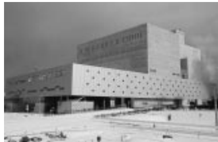
4月から本格稼働する新焼却炉
