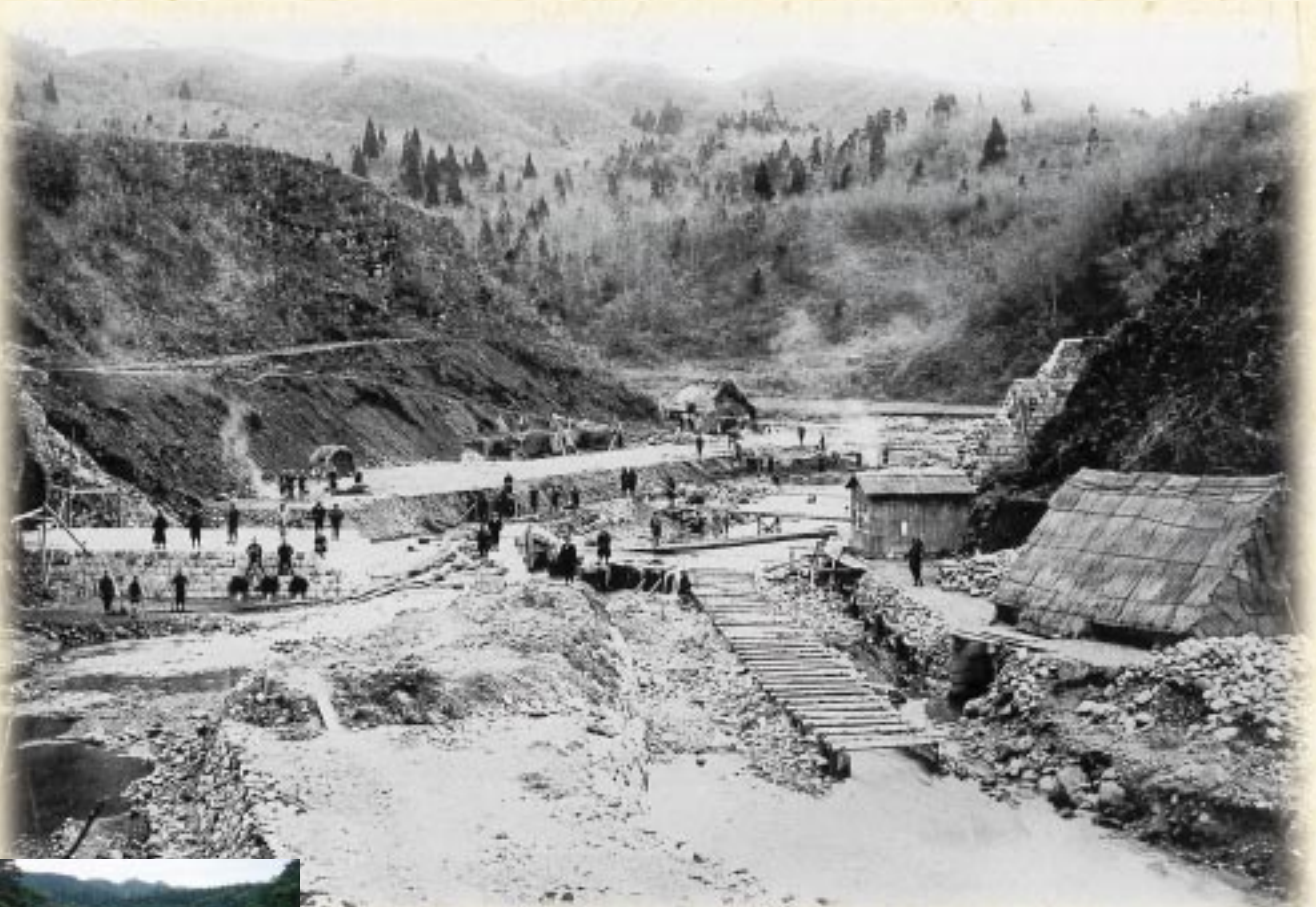
秋田市仁別での藤倉水源地の工事風景(明治36年ごろ)
