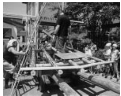
組み立て作業を間近で見つめます
