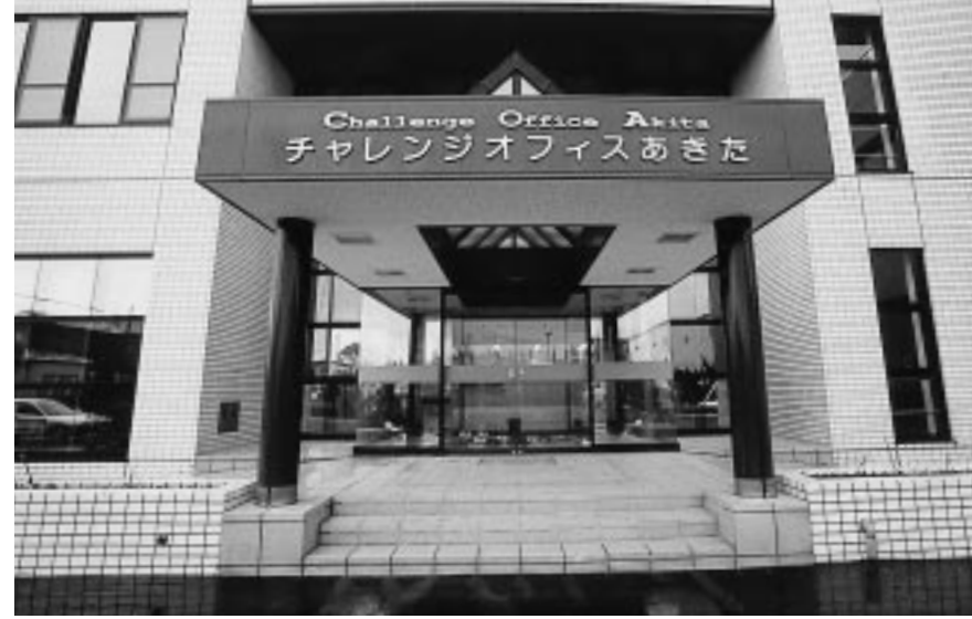
旧秋田市ガス局庁舎を改修し、創業支援施設に
