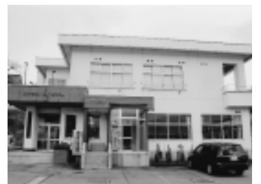
基幹集落センター(雄和町)
