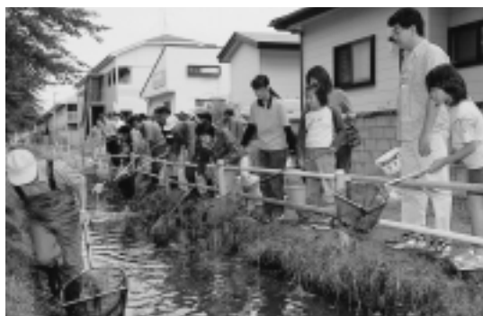
水路の工事を前に、メダカなどを保護
