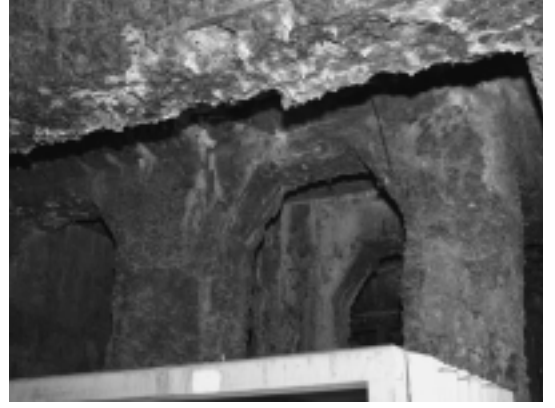
空襲の傷跡 高熱にさらされ、溶けてしまったコンクリート：日本石油秋田製油所の建物
