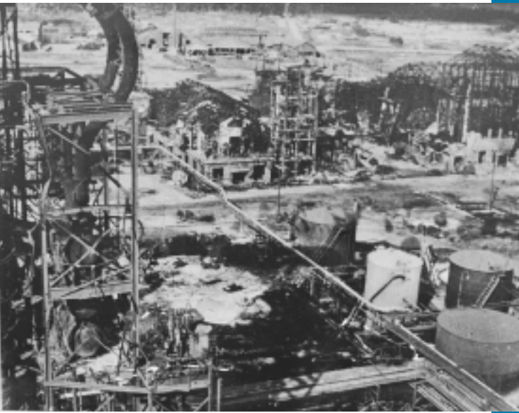
爆撃目標となった日石製油所は壊滅状態。多くの民家も被害を受けました
