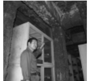
空襲の傷跡 高熱にさらされ、溶けてしまったコンクリート：日本石油秋田製油所の建物
