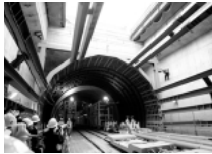
中央道路建設現場
