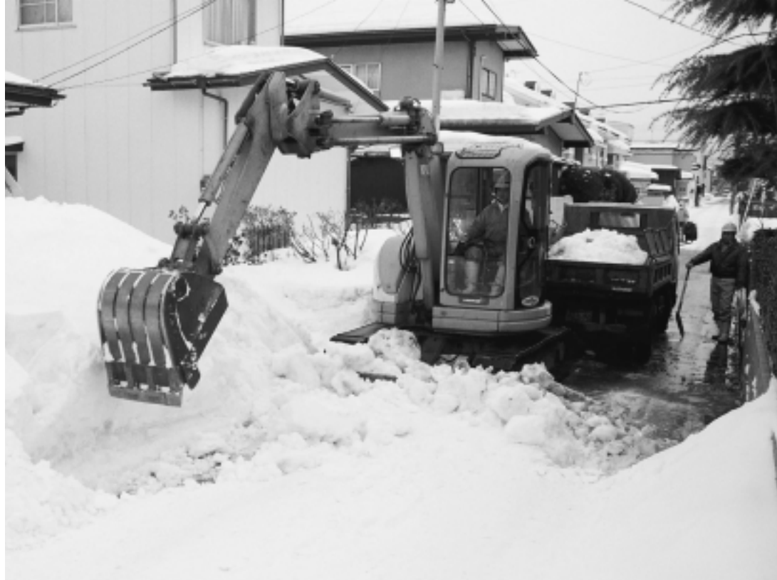
生活道路では、小回りのきくバックホーが活躍(1月24日、泉南一丁目)
